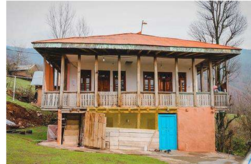
خانه های سواحل دریای خزر، به صورت برون گرا، با امکان تهویه طبیعی و با بام شیبدار
